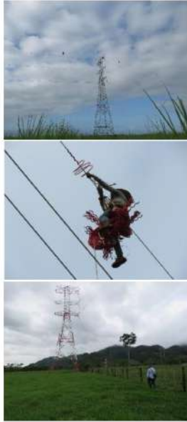
Fotografías colocación de desviadores de vuelo y monitoreo de colisiones de aves
