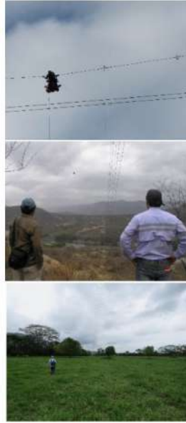
Fotografías colocación de desviadores de vuelo y monitoreo de colisiones de aves
