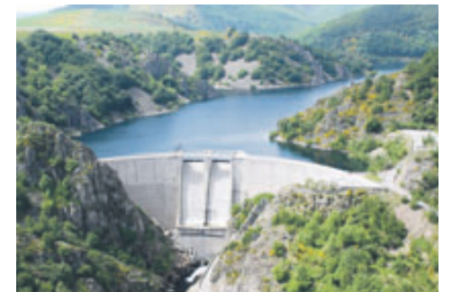
Presa Puylaurent, en Francia, es una hidroeléctrica tipo presa bóveda de hormigón, situada en los municipios de La Bastide-Puylaurent y Prévencières en el río Chassezac. FOTO EDH / CORTESÍA
